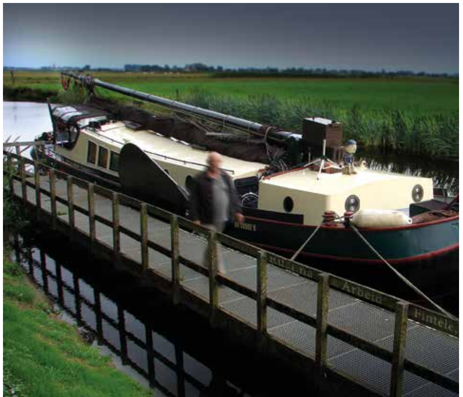
Yser – Fintele jetty
