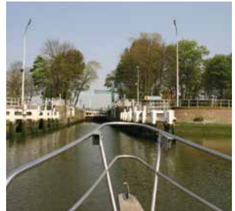
Yser – Ganzenpoort lock complex (Nieuwpoort)
